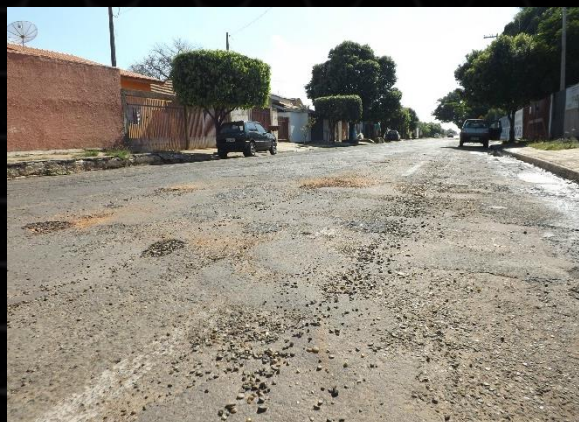
Rua com pedras, cascalhos e objetos pontiagudos que geram arrancamentos na banda de rodagem, principalmente de pneus on road.
