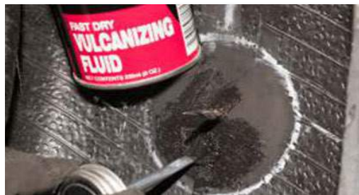
Figura 22. Aplicación del fluido en la zona texturizada
