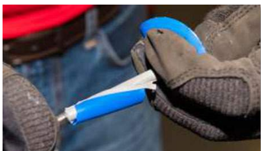
Figura 23. Eliminación de la protección
