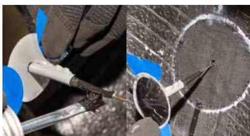
Figura 25. Aplicación de reparación de parte interna
